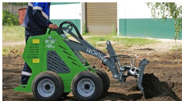
Работа отвалом на строительной площадке
