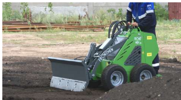
Ландшафтные работы (отвал плавающий отклоняющийся 1150)
