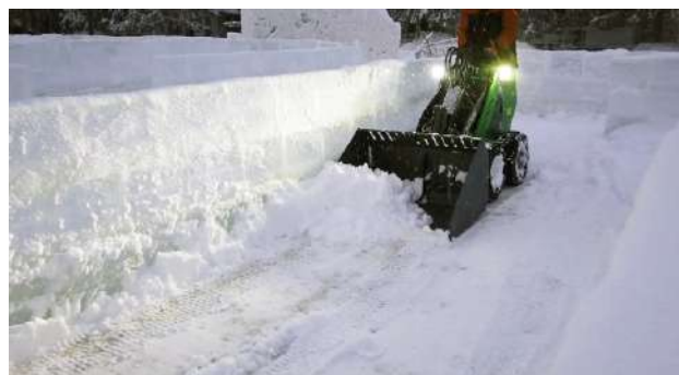
Чистка снега в стесненных условиях
